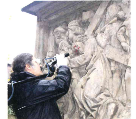
Als erste selbstständige Denkmalpflegewerkstatt Deutschlands setzten die Naumburger auf die Laserreinigung.
